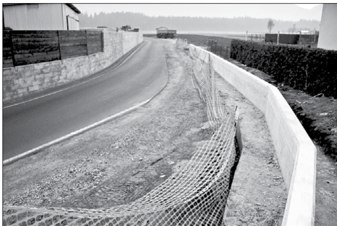
Cestišče na Trnovcu bo širše, nova protihrupna zaščita pa s pravnomočno dokumentacijo (Foto: Jože Miklavc)
