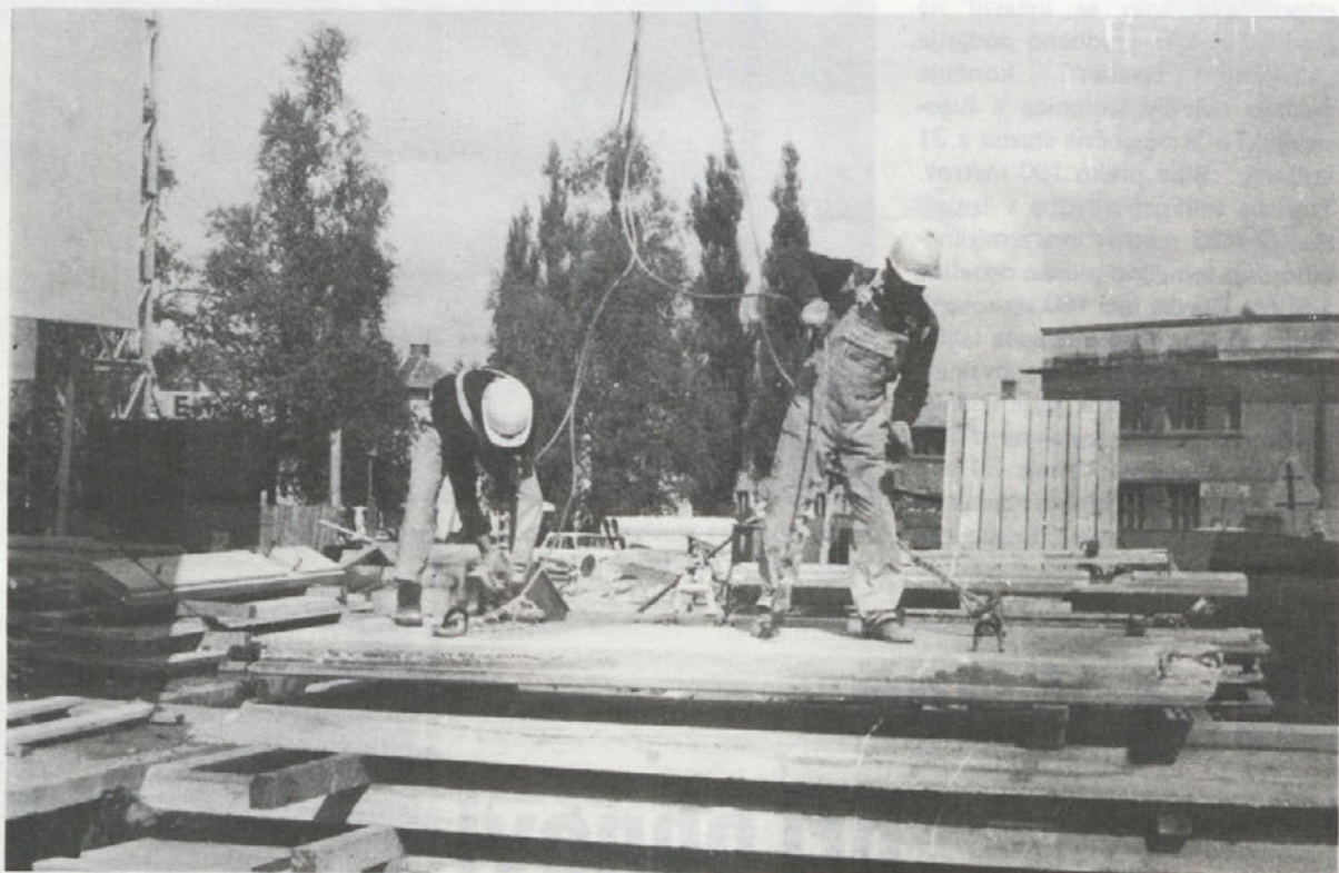
Delavca na sliki vpenjata jeklene vrvi v montažno fasadno ploščo Togrel, preden jo bo žerjav dvignil tja, kjer jo bodo montirali
