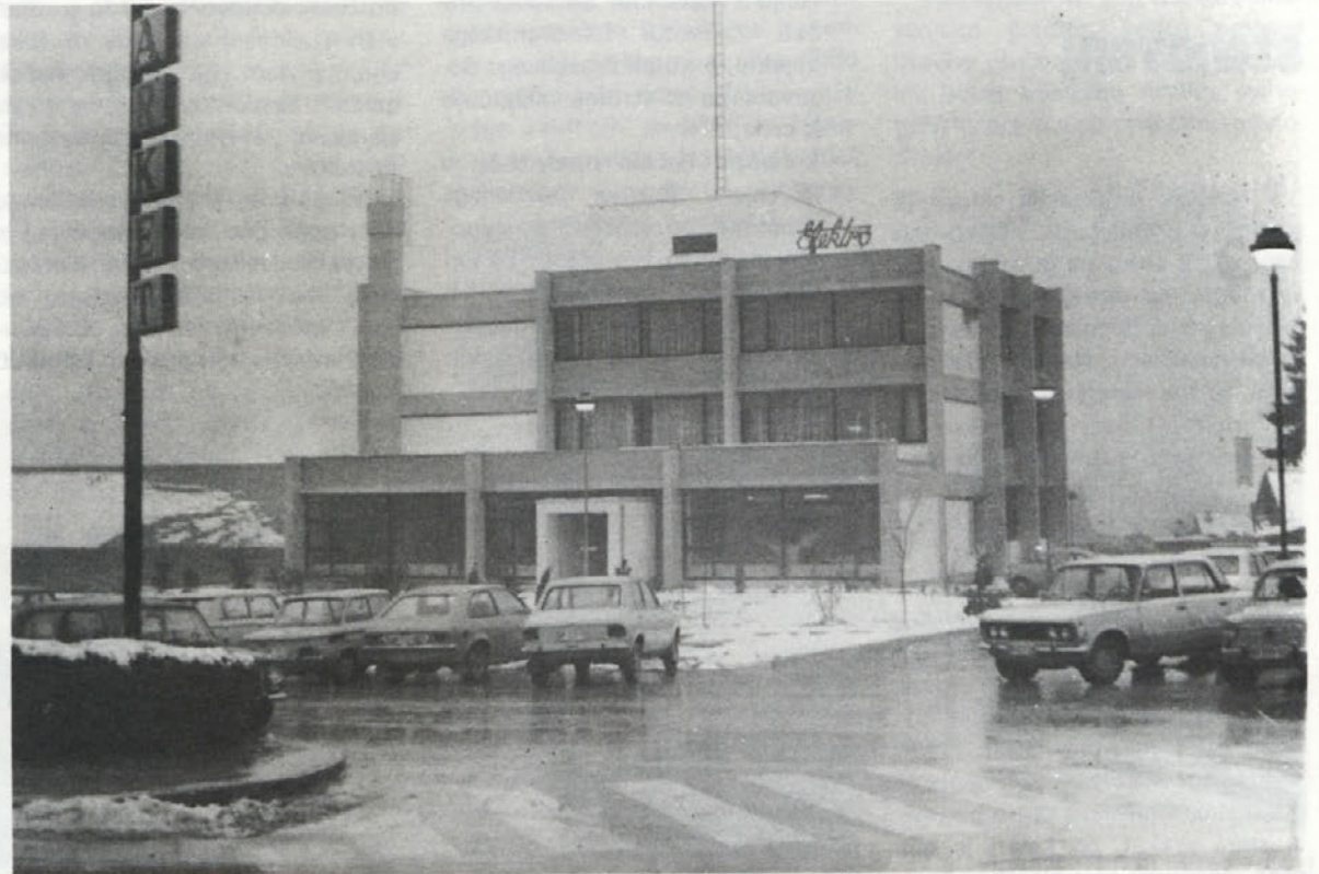
Nova upravna stavba Elektro Novo mesto, ki jo je v oktobru dogradil v Bršlinu v Novem mestu TOZD Gradbeni sektor Novo mesto
