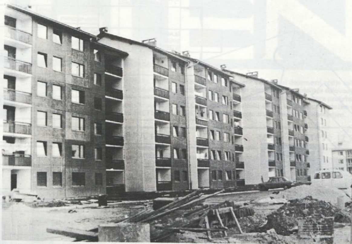
Pogled na del dograjenih stanovanjskih blokov v novi stanovanjski soseski Drska v Novem mestu
