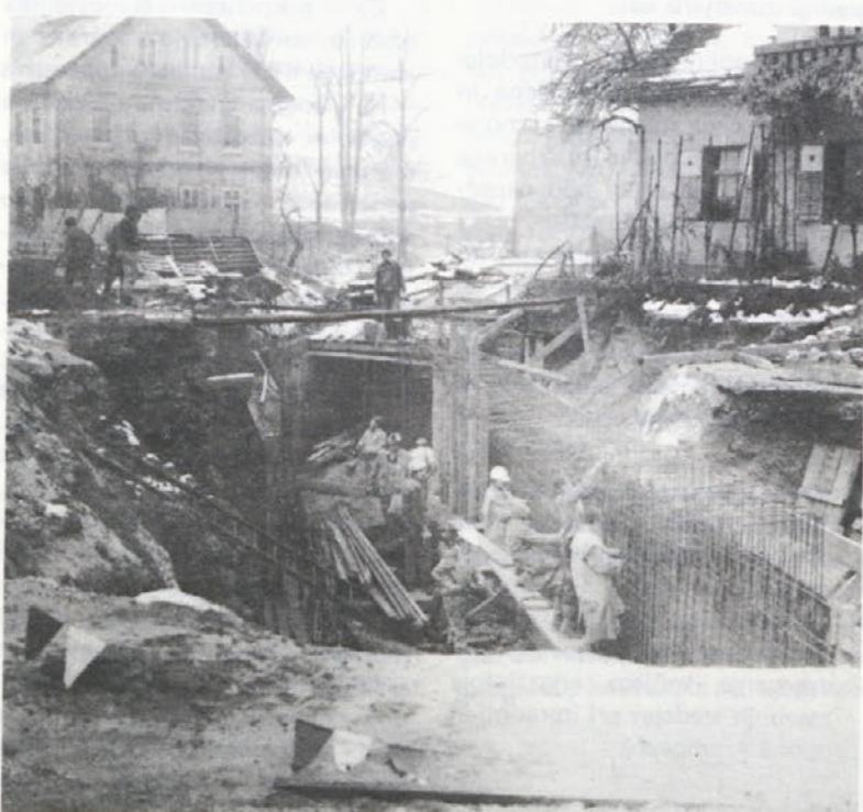
Gradnja podzemnega hodnika, ki bo povezoval novo bolnično kuhinjo s stavbami novomeške bolnišnice onkraj Šmihelske ceste v Novem mestu.
