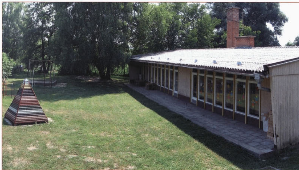
Vrtec Zvonček na Bregu bodo čez mesec dni porušili in nato bodo zgradili večjega. Foto: Aleš Černezel
