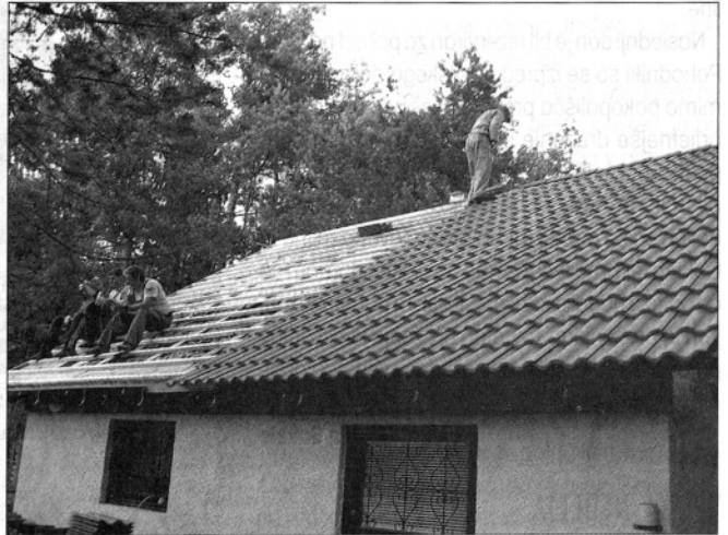
Člani zgornjesavinjskega kinološkega društva pri obnovi strehe
