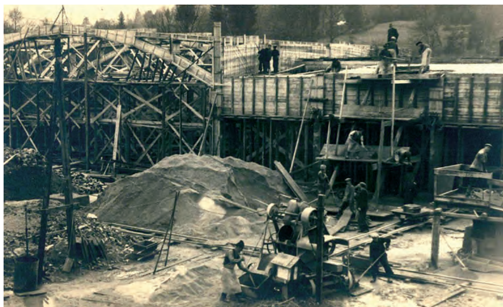
63. Gradbišče IUV z dragocenim gradbenim materialom in 500-litrskim mešalcem za beton. Avtor fotografije neznan. Leto 1946. Domoznanski oddelek CKV.
