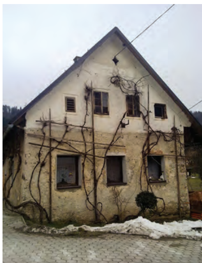
214. Strojarska domačija z zahoda, posneta leta 2015.
