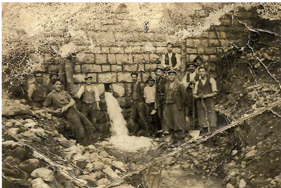
190. Gradnja pregrade za zadrževanje hudourniških naplavin na Podlipščici pri Rožancu, leta 1946. Med delavci je Franc Jurca-Gregurčev.
