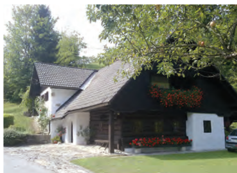
211. Lepo obnovljena Matečkova, danes Pirmanova hiša, leta 2013.
