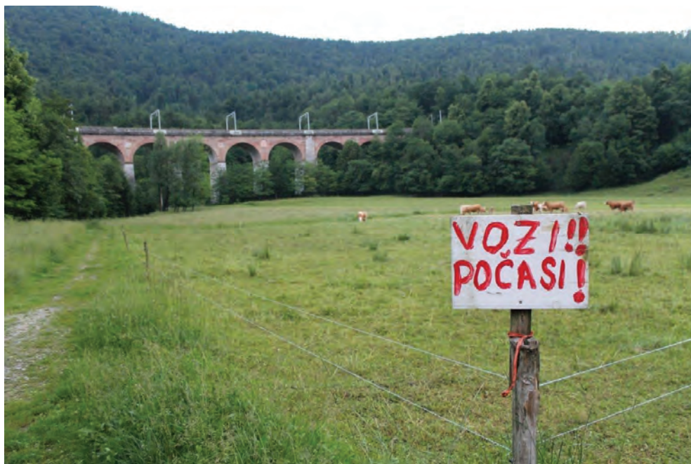
32. Po Jelenovem viaduktu še danes teče železniški promet (foto: Tatjana Oblak Milčinski, 2018).
