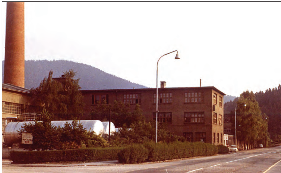
73. Pogled na pisarniški del IUUV s Tržaške ceste. V ospredju sta dve cisterni za mazutin in dve za toplo vodo. Kmalu po letu 1970. Avtor fotografije neznan. Domoznanski oddelek CKV.
