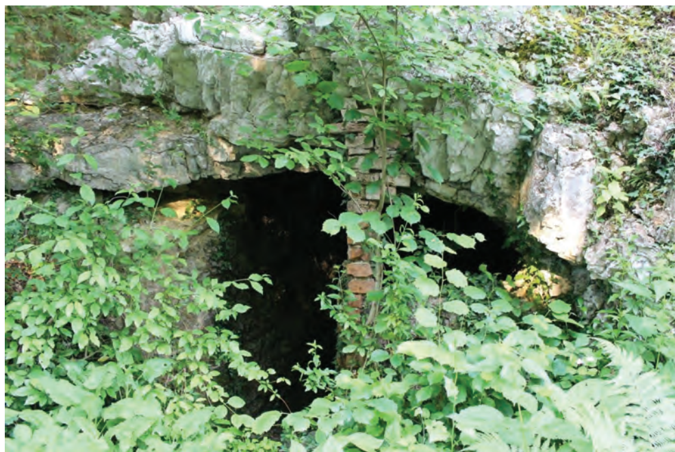
31. V bližini čuvajnice so vidni ostanki zaklonišča, ki so si ga leta 1945 v skalo izvrtali graditelji nemške proge za zaščito pred napadi angloameriških letal (foto: Tatjana Oblak Milčinski, 2018).
