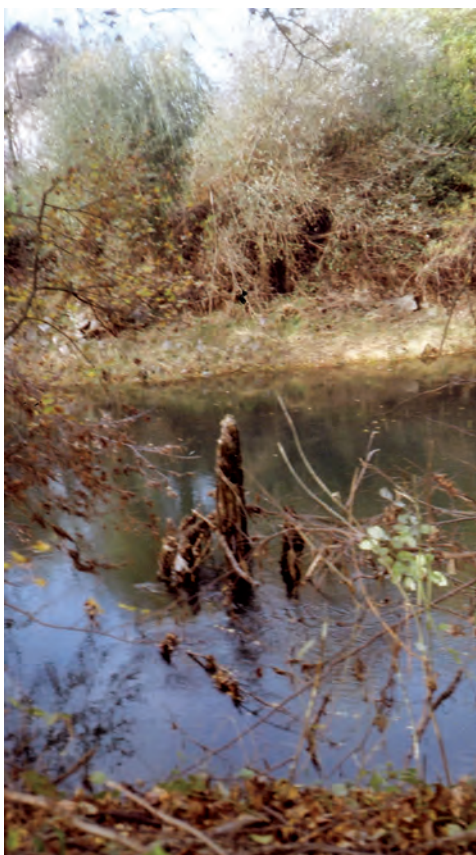
23. Ostanke lesenega mostu, ki so ga Nemci zgradili čez Ljubljano na Vrhniki leta 1944, ko so načrtovali povezati vrhniško progo z Južno železnico. (Slikano z desnega brega reke.) V ozadju levo stavba na Opekarski c. 18 (podjetje LEDINA-AR inženiring). Foto: Zdenek Mohar, november 2017.
