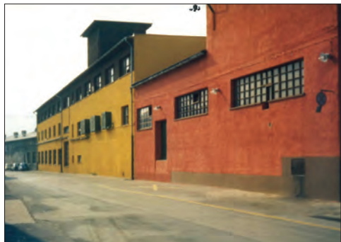
71. Pogled na energetska obrat z nizom delavnic vzdrževalne dejavnosti na severovzhodnem delu kompleksa IUUV. Okrog leta 1985. Avtor fotografije neznan. Domoznanski oddelek CKV.
