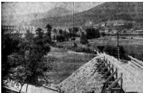
24. Preko ravnine grade v širokem loku nov železniški nasip. V ozadju opuščeni borovniški viadukt. Pod njegovimi širokimi oboki na levi bo zgrajena nova borovniška postaja. Slovenski poročevalec, 9. junij 1946.
