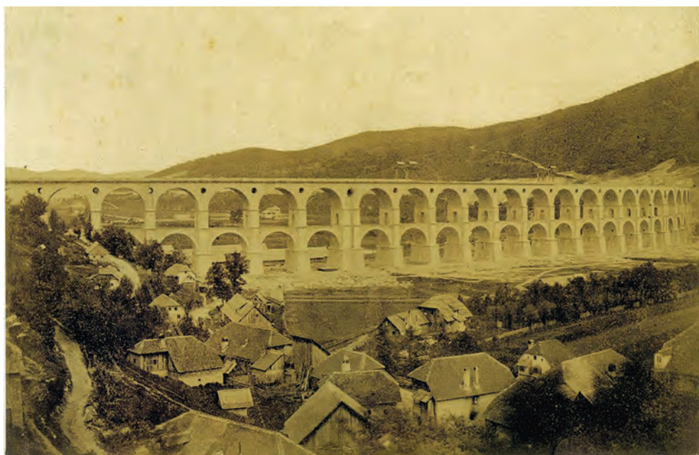
18. Borovniški viadukt - pogled proti hribovju, list iz albuma Wien-Triester Bahn , albuminska fotografija, inv. št. F-1601/12. Foto: Tomaž Lauko, dokumentacija Grafičnega kabineta NMS.
