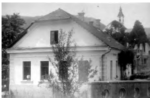
248. Podlipska šola, obdobje med vojnama. Spredaj ograja mostu čez Podlipščico, zadaj cerkev sv. Brikcija na griču (ZAL, VRH 46).
