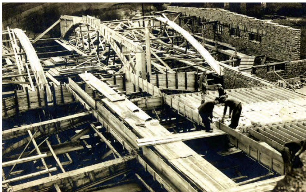
62. Gradnja oddelka za strojenje svinjskih kož. Desno spredaj delavci izdelujejo opaž za Ferjanove nosilce . Avtor fotografije neznan. Leto 1946. Domoznanski oddelek CKV.
