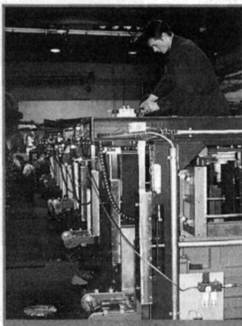
Sedem naprav (mask) za polnjenje ohišij zamrzovalnih aparatov, izdelanih v Gorenju Indop.
