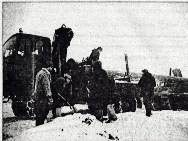
Postavitev nove transformatorske postaje na Kovskem vrhu.
