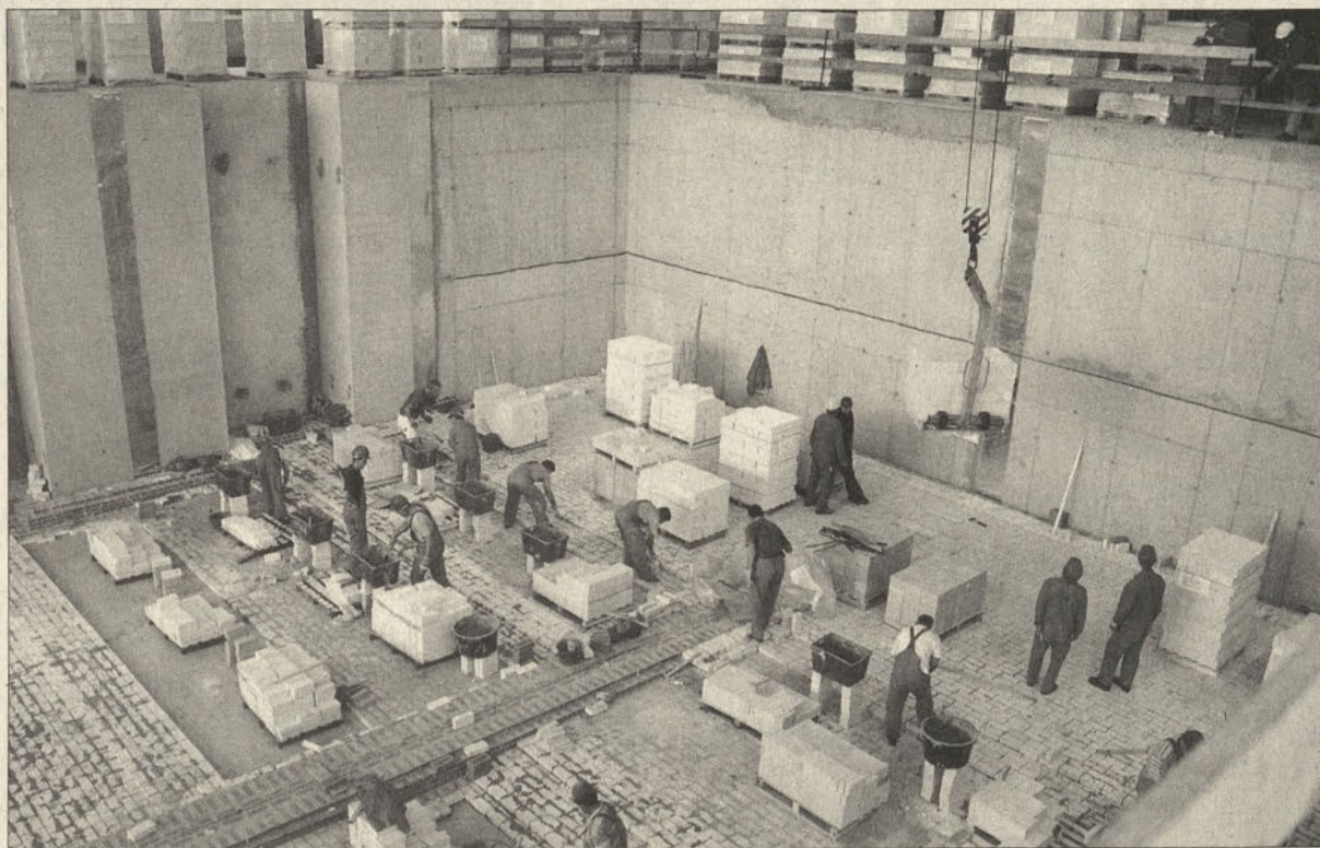
Obzidava kalcinacijske peči
