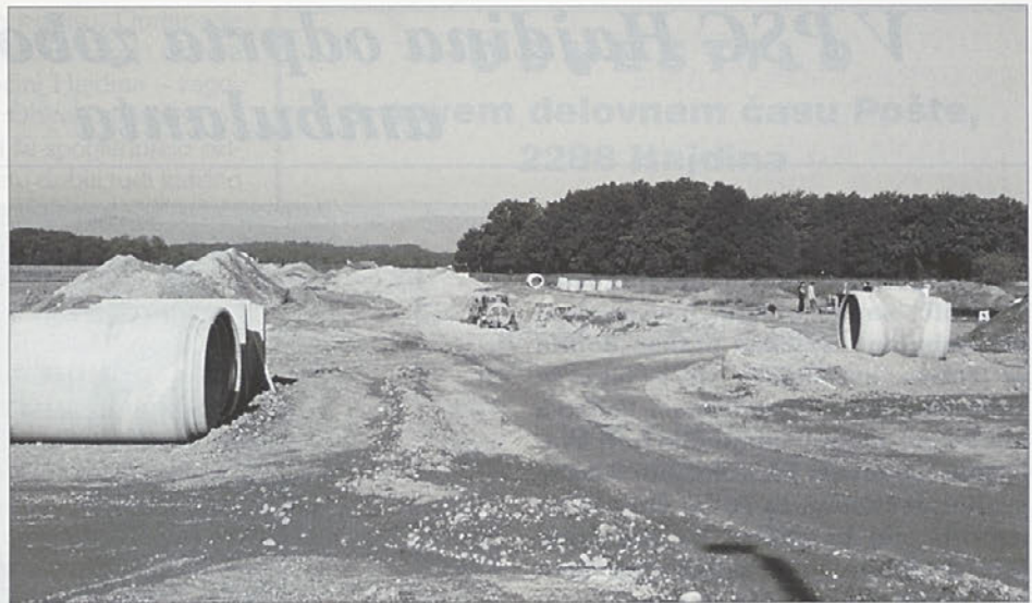
Cestno gradbišče v Dražencih v začetku oktobra, kjer so opravili že veliko pripravljalnih del za pričetek izgradnje nadvoza ...
