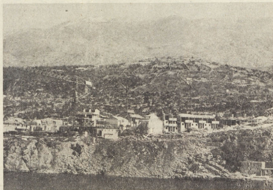
Pogled na gradbišče Stinice
