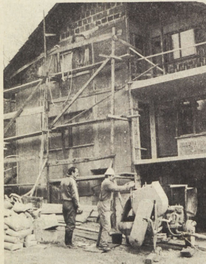
Prototipna izdelava fasade tip Pionir — Novoterm
