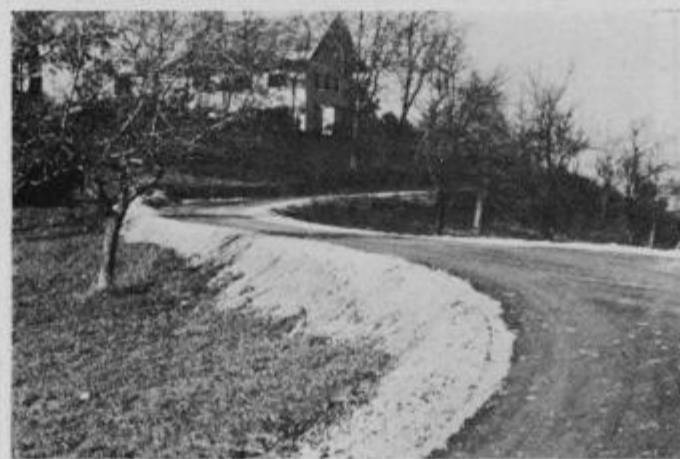
Del asfaltirane ceste Zgornji Podlehnik—Ljubstava.
