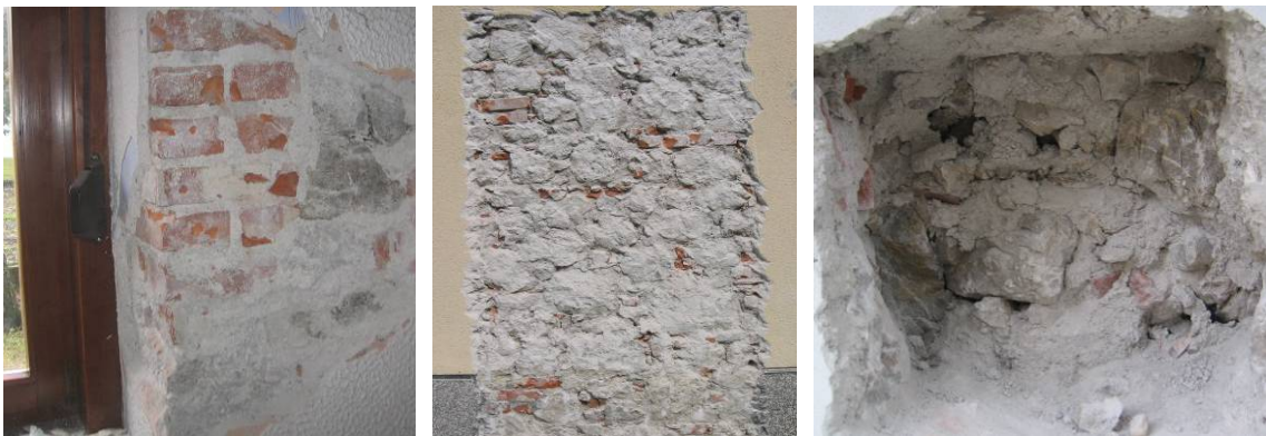
Slika 5.18: Izvedba površinskega (POZ 1-C1) in globinskega sondiranja (POZ 9) zidu Fig. 5.18: Surface (POS 1-C1) and in-depth probing (POS 9) of the wall
