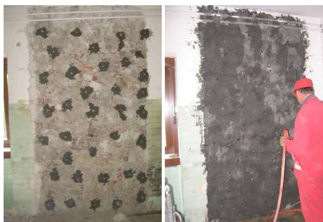
Slika 5.11: Priprava zidu 1-C1 in izvedba sistematičnega injektiranja Fig. 5.11: Preparation of the wall 1-C1 and execution of grout injection
