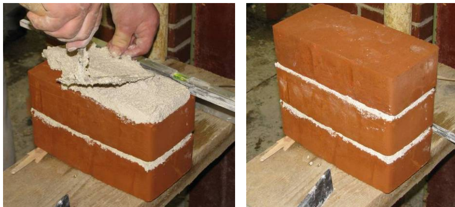
Slika 4.4: Pozidava opečnega trojčka Fig. 4.4: Construction of a triplet specimen
