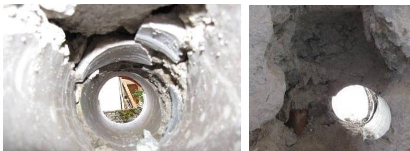
Slika 5.41: Vrtina in globinska sonda izvedena v spodnji polovici zidu 6
