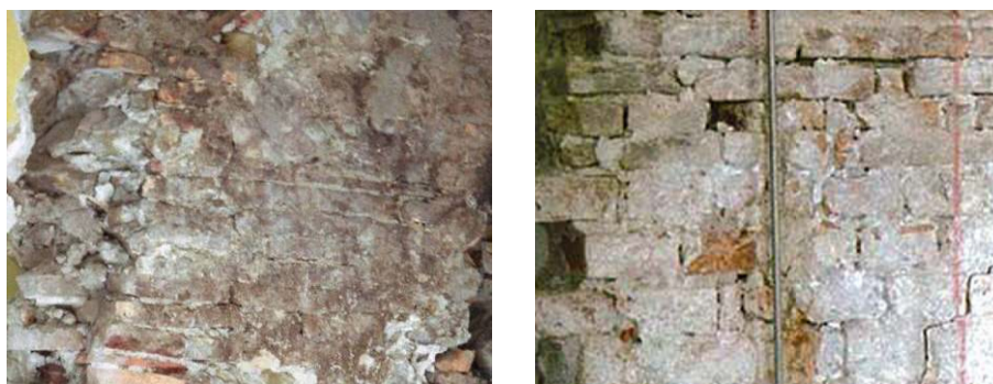
Slika 2.18: Tekstura mešanega kamnito-opečnega zidu v stavbi iz 17. stoletja ter opečnega zidu v stavbi iz 19. stoletja (foto arhiv ZAG)
