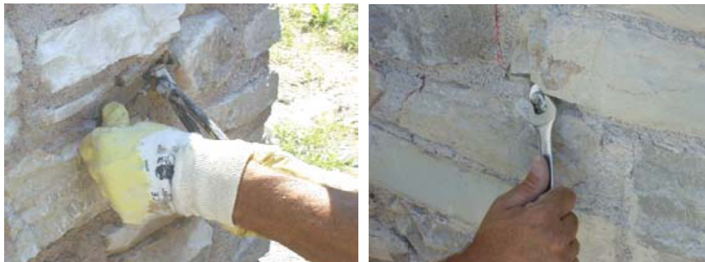
Slika 2.35: Iz leve: pritrjevanje prečnih sider s krivljenjem v primeru rebraste armature, in z vijačenjem v primeru gladke armature z vrezanim navojem (Valuzzi in sod., 2004)
