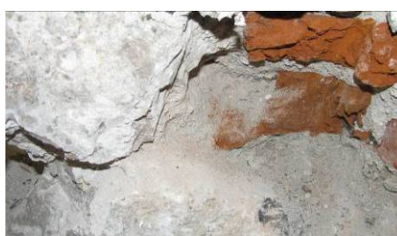
Slika 5.30: Jedro in globinska sonda, izvedena ob vpetju zidu 1-C1 Fig. 5.30: Core and in-depth probing at the bottom of the wall 1-C1
