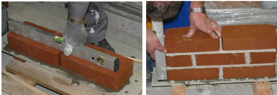
Slika 4.2: Polaganje prvih zidakov v cementno malto (levo) in nadaljevanje pozidave z apneni malto (desno)
