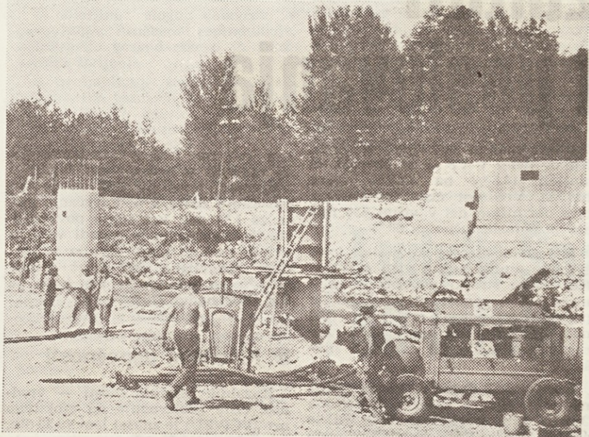
Rečni oporniki so postavljeni in kmalu bodo začeli montirati nosilce
