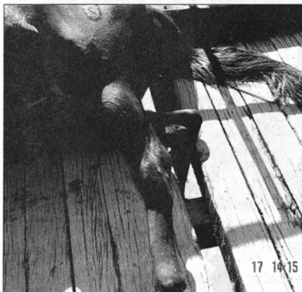
Sanacija mostu bo verjetno stala manj kot milijon tolarjev vreden konj, ki se je poškodoval na njem (foto: Matjaž Časl)
