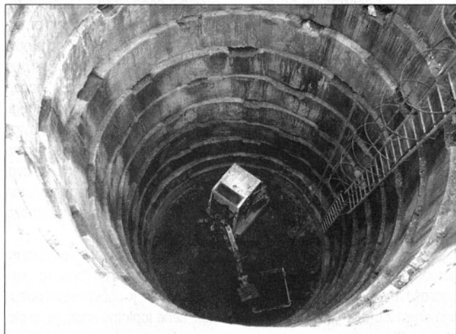
Drenaža, kjer se bodo pod nivojem plaz u v globini 20 metrom zbirale podtalne vode (foto: EMS)
