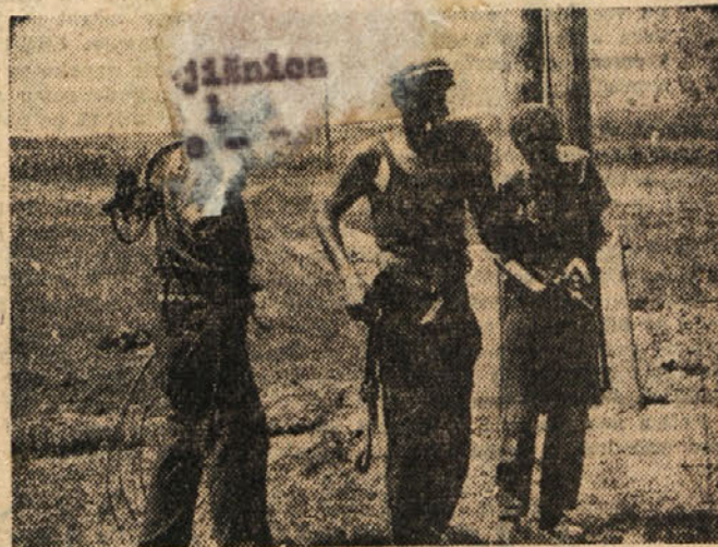
ZAKLJUČNA DELA NA DALJNOVODU
