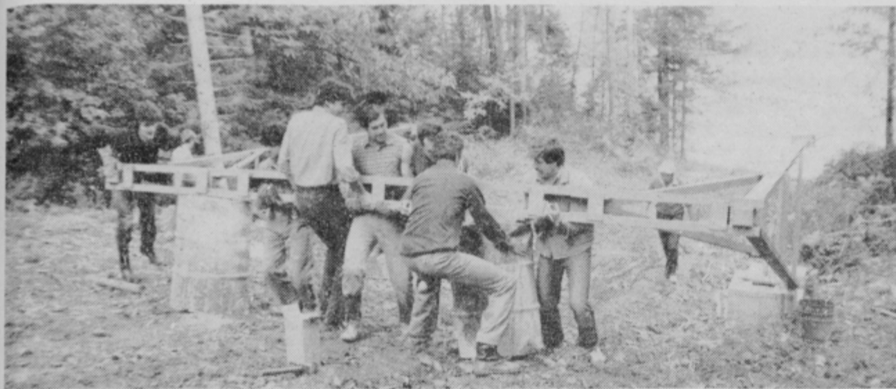
Večino fizičnih del so pri izgradnji smučišča Gozdnik opravili krajanji Griž, delavci nekaterih delovnih organizacij ter člani društev in učenci šol na prostovoljnih delovnih akcijah. (Foto: L. Korber)
