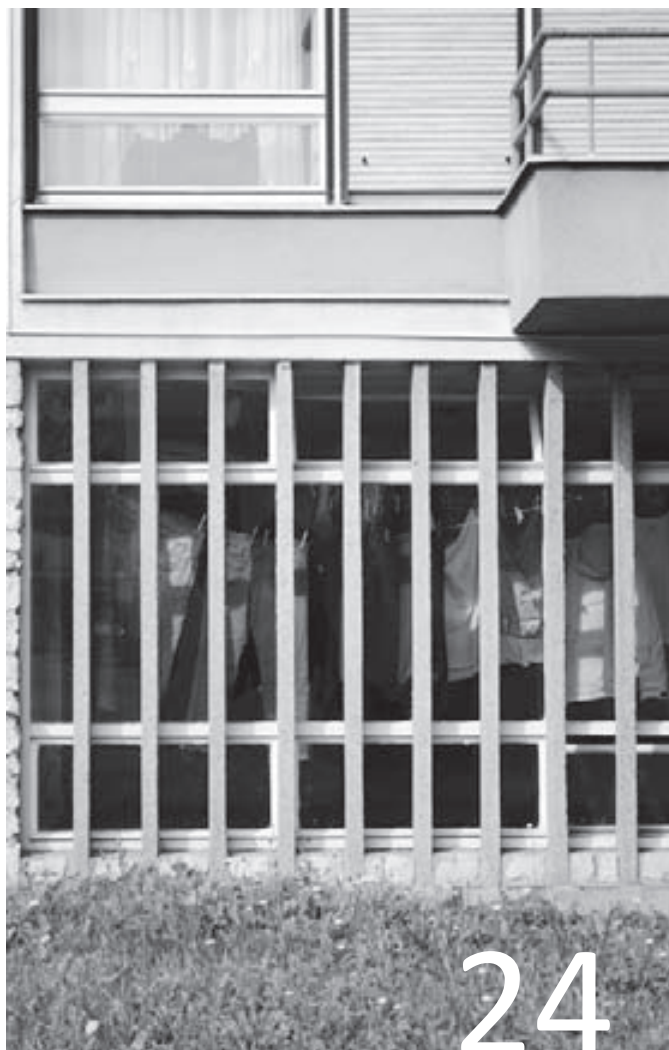
Stanovanjski blok_1965_ Ulica arhitekta Novaka 7
