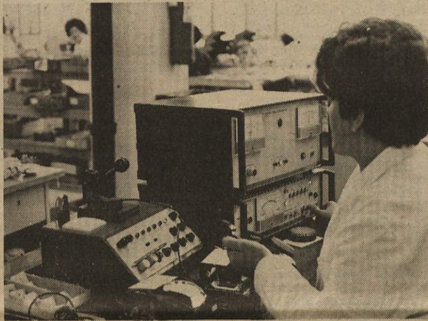
Naprave za kontrolo zvonca, številčnikov ter refleksijskega slabljenja ob tekočem traku telefonskega aparata.
