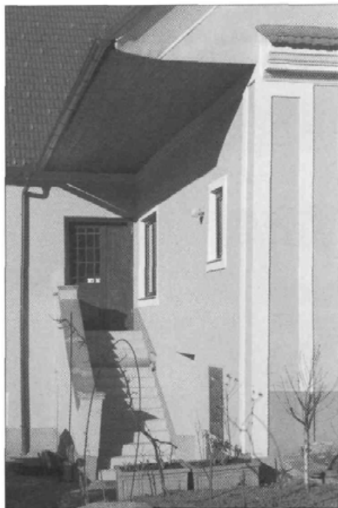
83. Obnovljeno stopnišče Tomšičeve hiše, 2009. (Foto: Š. Habič)
