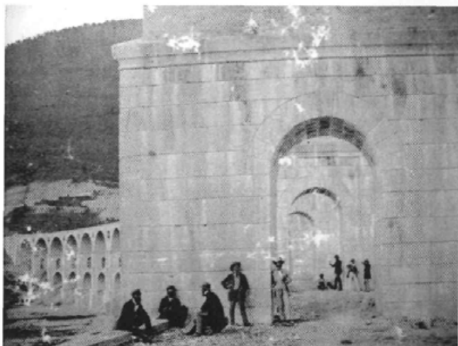
224. Gornja etaža borovniškega mosta.
