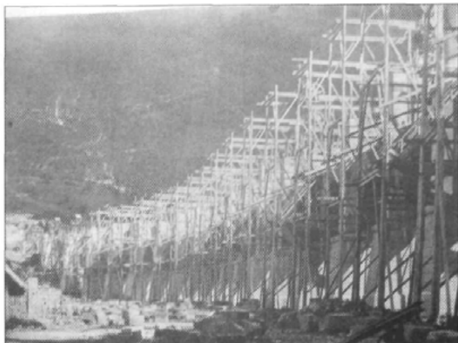
223. Borovniški most v gradnji, september 1856.
