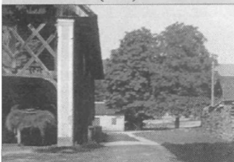
73. Tomšičev kozolec toplar in zadaj hišica pod kostanjema, 1934.
