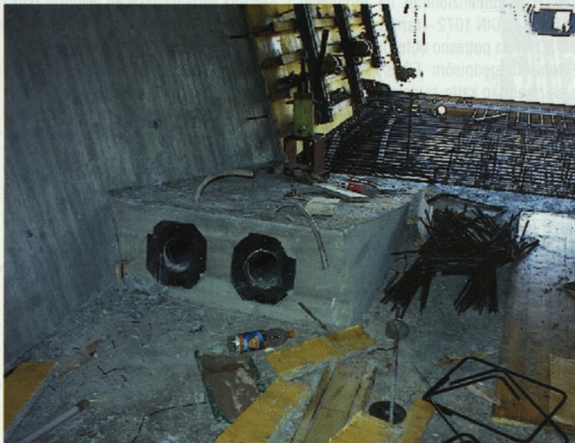
Slika 4b: Bradavica za sidranje spodnjih sovprežnih kablov
