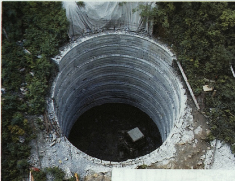
Slika 8b: Izvajanje izkopa za vodnjak
