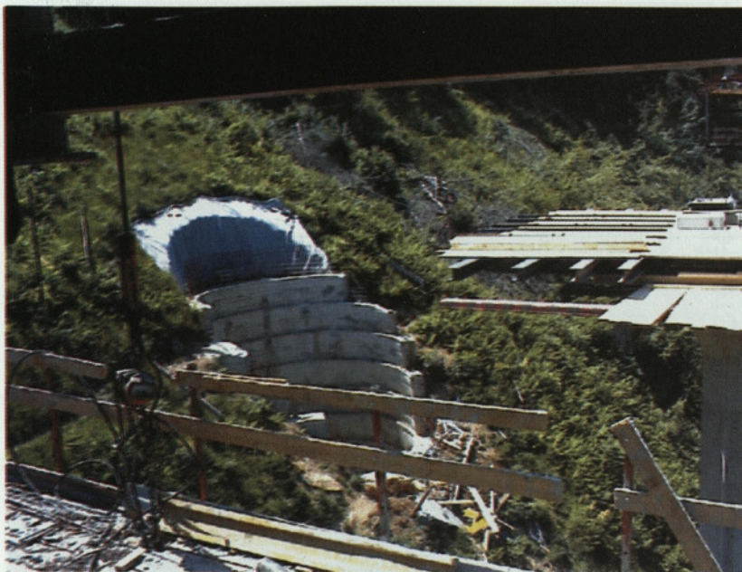
Slika 8a: Izvajanje izkopa za vodnjak
