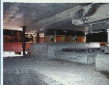
Slika 9: Vpetje prekladne konstrukcije v kapo stebra v času gradnje
