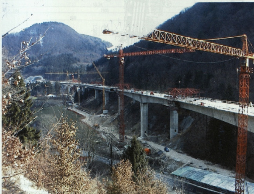
Slika 1: Gradnja viadukta Ločica (februar 2001)
