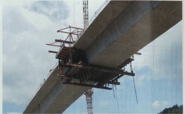
Slika 10d: Izvedba vezne lamele VL23 (spajanje prekladne konstrukcije v 2. polju)
