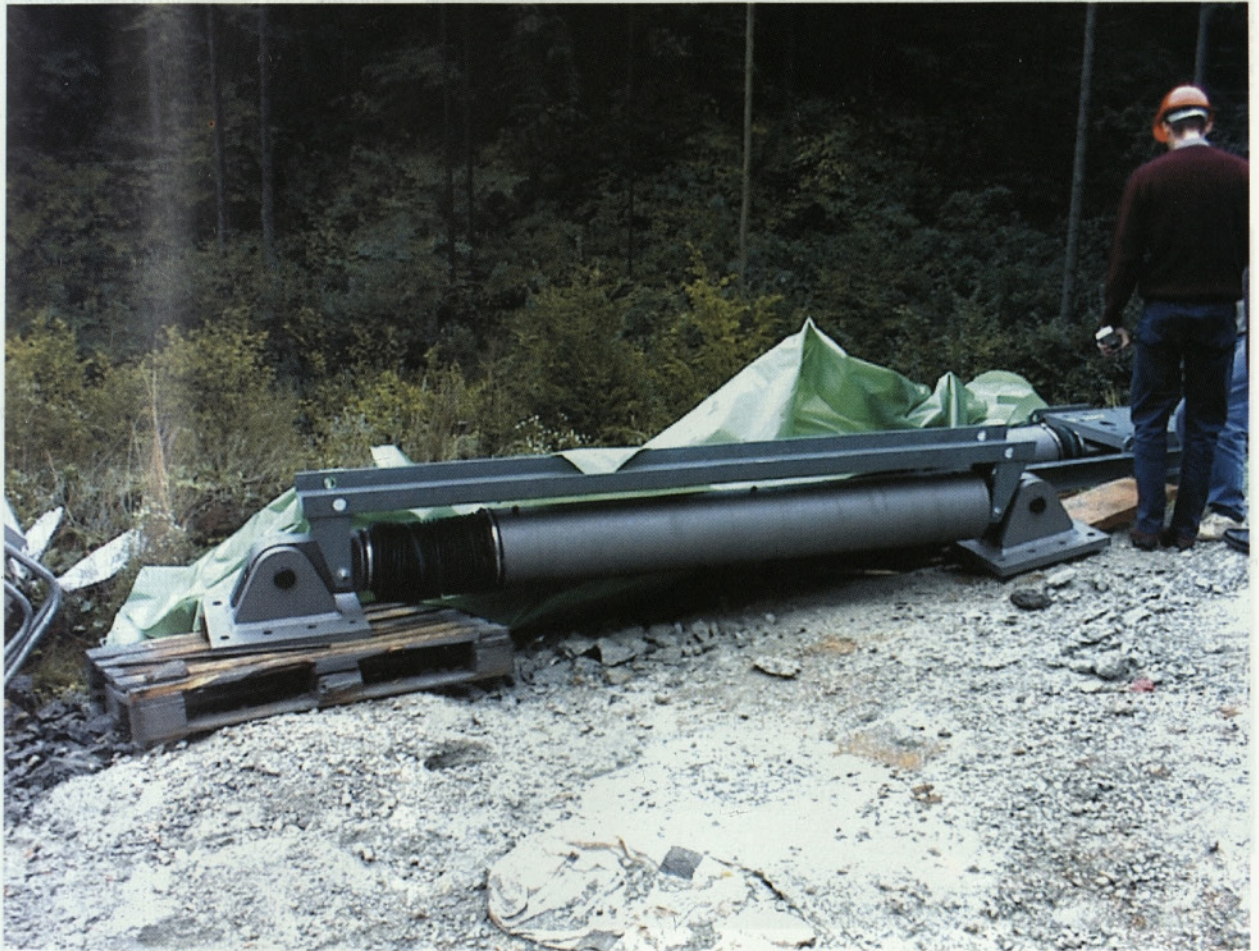
Slika 7: Dušilec, ki se namesti na vmesnih podporah v oseh 2,3, 9 in 10.
