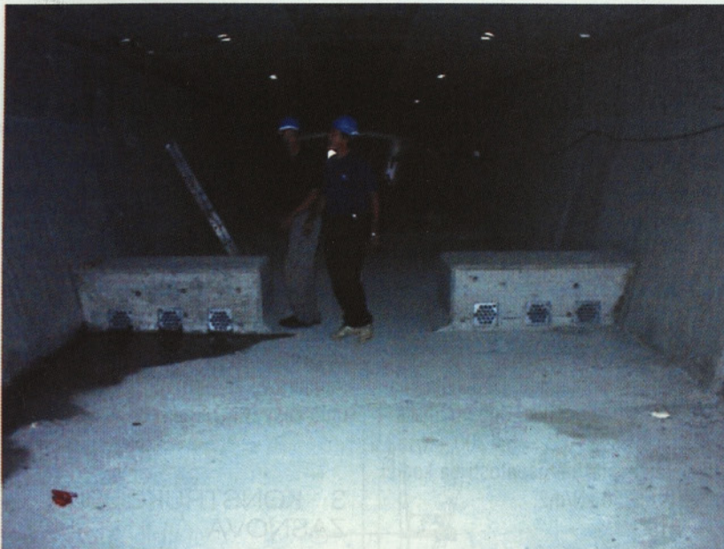
Slika 4a: Spodnji deviatorji za zunanje kable
