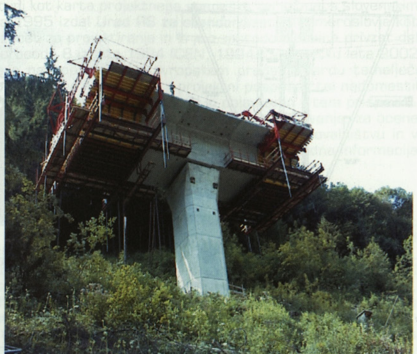
Slika 10a: Izvedba 2. lamele M6
