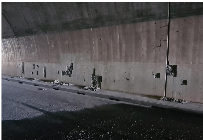
Slika 7. Priprava površin manjših lokalnih sanacij, 9. 7. 2023 (foto: Ponting, d. o. o.).
