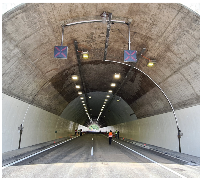
Slika 12. Pokriti vkop po sanaciji, julij 2023 (foto: Ponting, d. o. o.).
