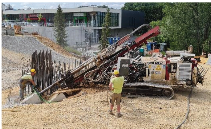
Slika 13. Vrтанje sider opornika 1.
