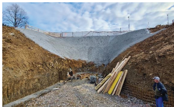
Slika 9. Pogled na torkretiran izkop vodnjaka 1.
