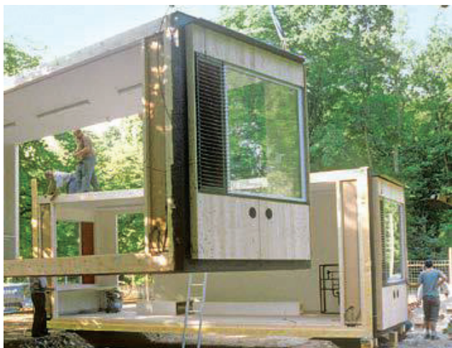
Slika 6. Züri-Modular; sestavljanje modulov (levo) in paviljon prve generacije (desno) [Rinke, 2020].
