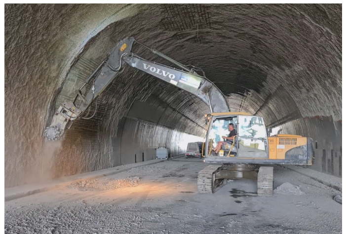
Slika 8. Lokalno poglobljanje površine z bradavičastim rezkarjem za vgradnjo mrež, 13. 7. 2023 (foto: Ponting, d. o. o.).
