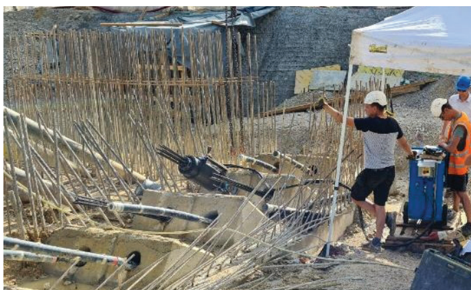
Slika 15. Napenjanje sider spodnjega nivoja opornika 1.
