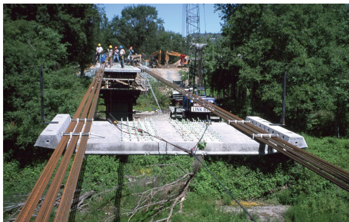
Slika 19. Montaža z vlečenjem elementov po vrveh [Stráský, 2023].
