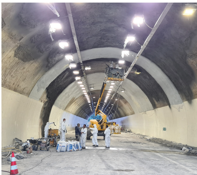
Slika 11. Brizganje mikroarmirane sanacijske malte (foto: Ponting, d. o. o.).
