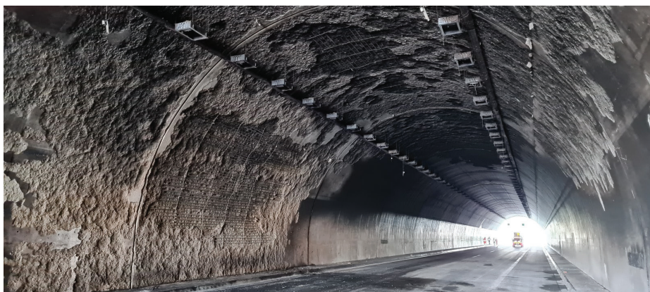
Slika 4. Stanje po požaru v pokritem vkopu Malečnik, 27. 6. 2023 (foto: Ponting, d. o. o.).
