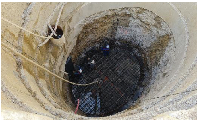
Slika 11. Armatura dna vodnjaka 1.
