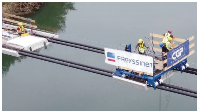
Slika 20. Montaža elementov s specialnim vozičkom.
