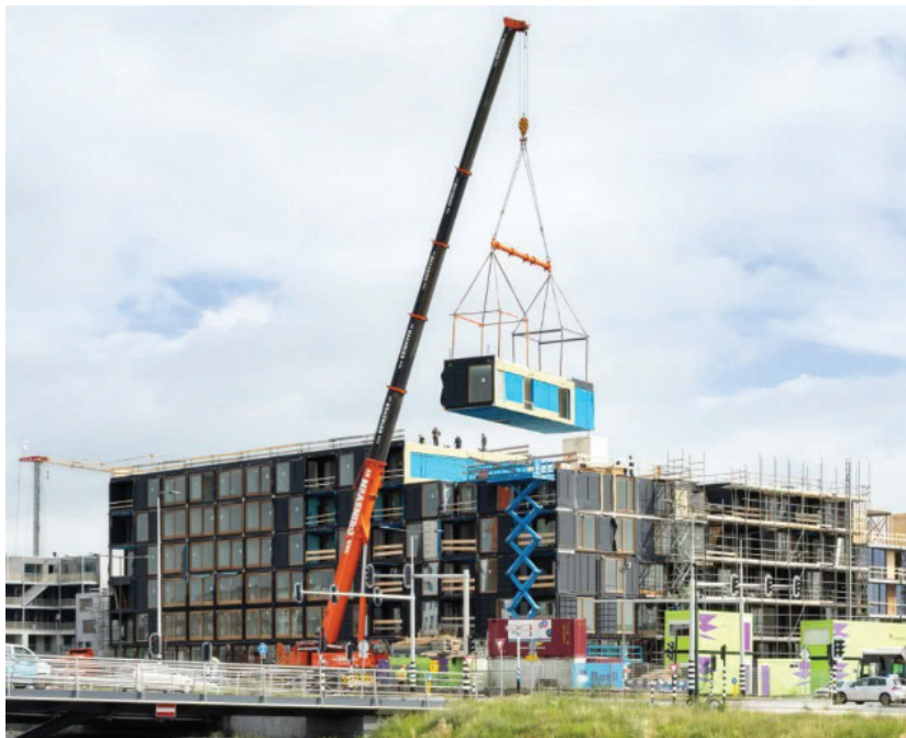
Slika 5. Juf Nienke; sestavljanje modulov (levo) in tloris tipične etaže (desno) [SEARCH, 2023].
