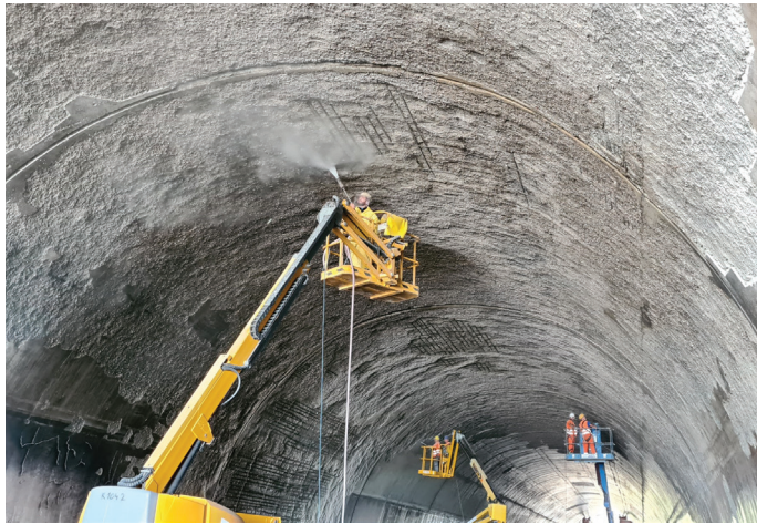
Slika 5. Visokotlačno čiščenje v pokritem vkopu Malečnik, 9. 7. 2023 (foto: Ponting, d. o. o.).
