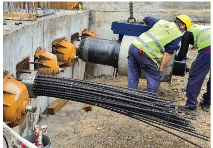
Slika 22. Napanjanje kablov 2. faze z napanjalko CC1500.
