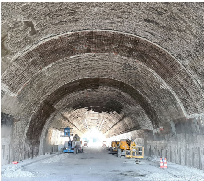
Slika 9. Vgrajene armaturne mreže, 16. 7. 2023 (foto: Ponting, d. o. o.).
