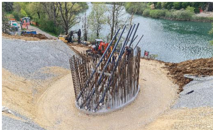
Slika 12. Opažne cevi v zgornjem sloju vodnjaka 1.
