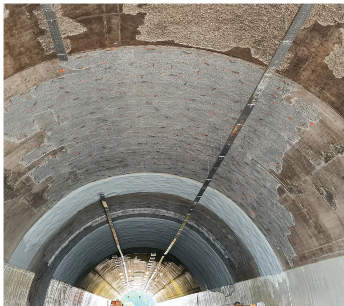
Slika 10. Izveden brizgani beton, vgrajene pocinkane žične mreže in izvajanje elektroinstalacij (foto: Ponting, d. o. o.).
