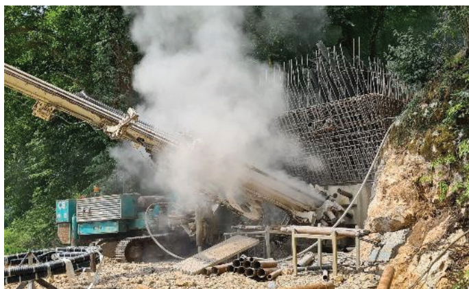
Slika 14. Vrتانje sider opornika 2.
