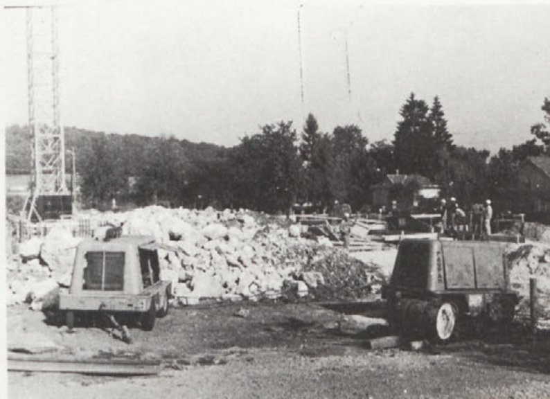
Ker je teren kamnit ne gre pri gradnji zdravstvenega doma v Novem mestu brez pomoči kompresorjev
