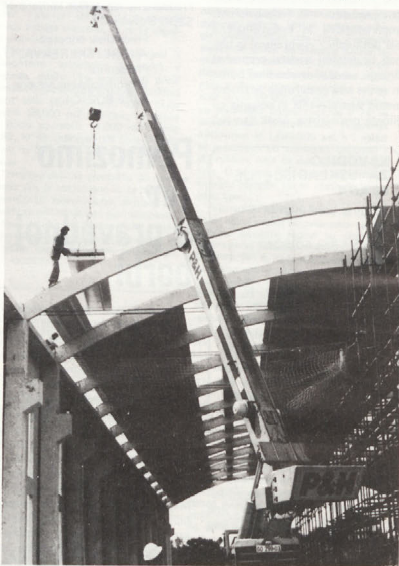
Gradnja TOGRELOVE ločne montažne dvorane (FOTO: G. Rovani)
