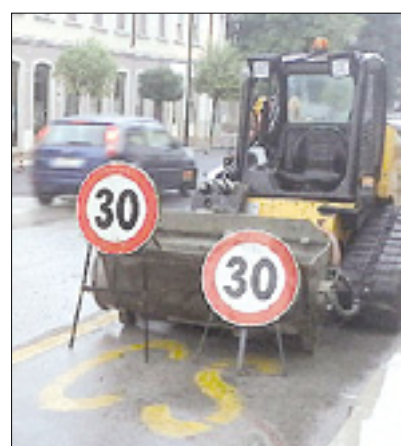
Gradbišče na tržiški ulici
