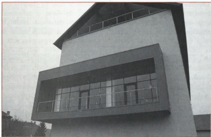
Obnovljena Mlekarna, novo poslovno-stanovanjsko poslopje, neposredno ob starem mestnem jedru Ptujja.
