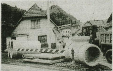
Polaganje kanalizacijskih cevi sredi Motnika
