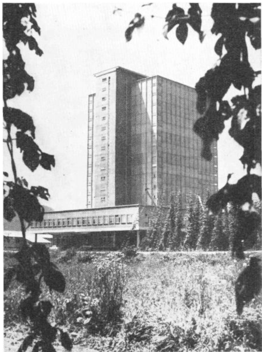
Novo osrednje skladišče za hmelj v Zalcu.
