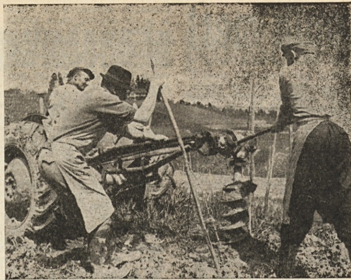
Vrtanje lukenj za sohe je zahtevalo največjo previdnost. Posnetek: A. Ileč
