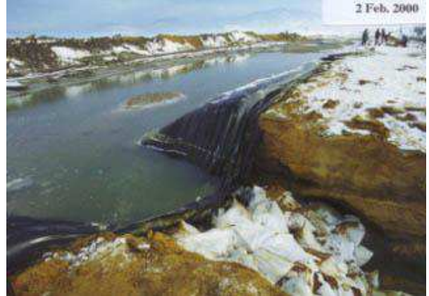
Slika 10: Pregrada Aurul - tri dni po prebitju pregrade
