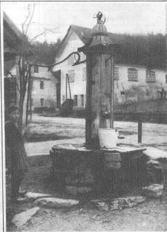
Vzor slabega vodnjaka, ker je nezadostno pokrit in daje tako nezdravo okuženo vodo.
