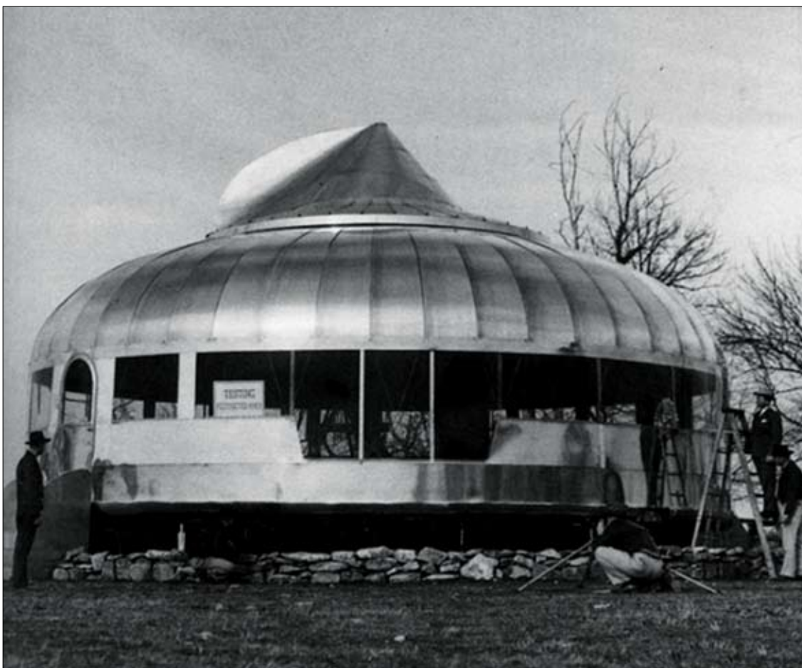
Konstruktivske elemente hiše Wichita so iz tovarne dostavili v dveh velikih cilindričnih paketih.
