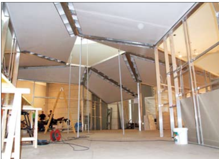
Slika 7: Montaža in oblačenje konstrukcije paviljona (Foto: RPS)
