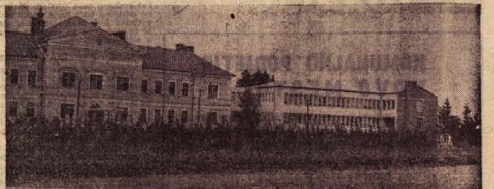
Nova stavba brežiške bolnišnice, ki so jo zgradili lani in letos, je že doslej precej omilila pomanjkanje prostora. Novo poslopje se lepo zliva v celoto s starim in potniku prav leto predstavi Brežice ob prihodu iz bizeljske in dobovske strani
