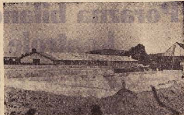
Sodobno urejeni hlev za 110 glav živine na obratu KZ Brežice v Cerkljah. V ospredju so betonski koritasti silosi za spravljjanje silirane krme.
