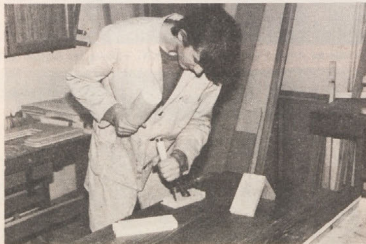
Ročno izdelovanje konstrukcijske vezi
