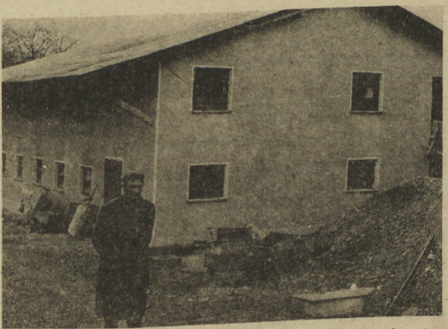
Dezider Kranjec iz Domanjševca je nadstropne svinjake uredil po lastni zamisli. V spodnjem delu so pitanci, v nadstropju pa plemenske svinje in pujski. Veliko dela pri gradnji hleva je opravil sam, saj je Dezider po poklicu zidar.
