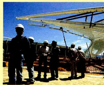
Osrednji stadion končno dobiva streho.
