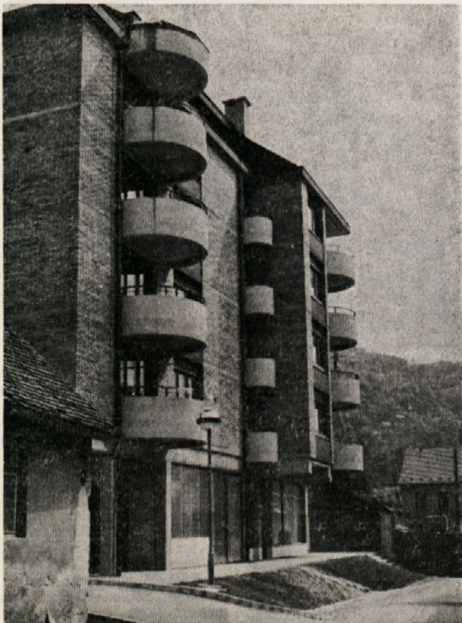
Stanovanjsko poslovni objekt v Radečah. Foto V. Š.
