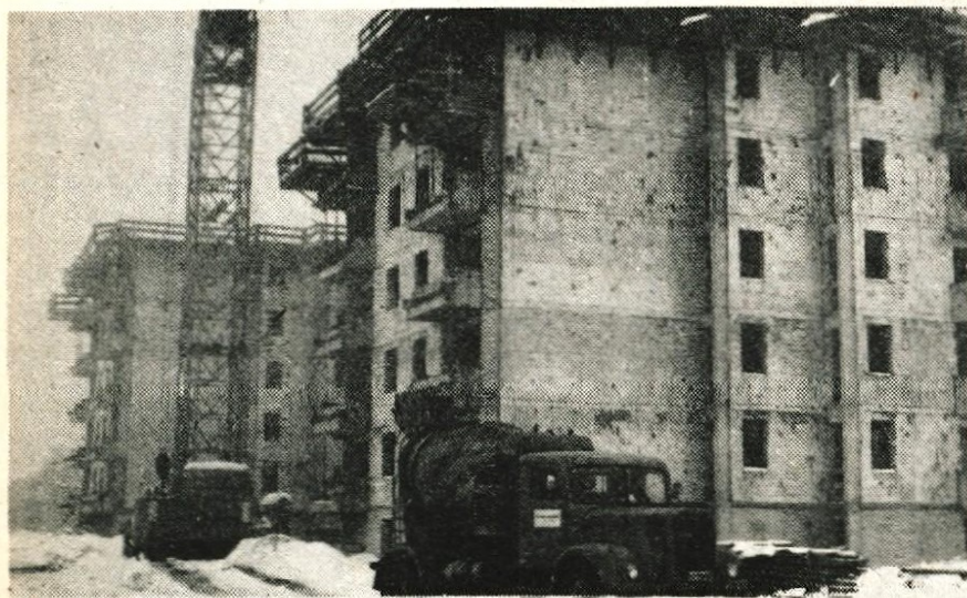
Z novo betonarno bo zagotovljena dovolj betona za nemoteno gradnjo. — Foto: F. Perdan
