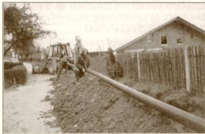
Z gradbišča na Grajenščaku.
