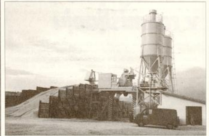
Nova pridobitev podjetja Žiher je betonarna v Ormožu. Foto: TM
