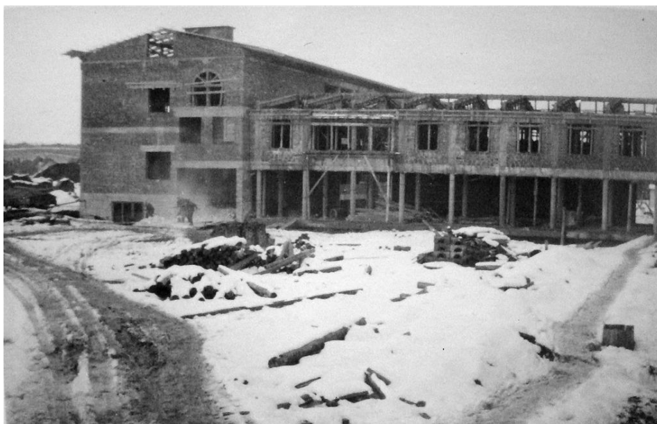
Šola med gradnjo trakta B in C, leto 1957/58
