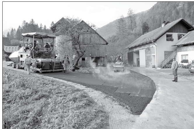
Asfaltiranje javne poti Hribr-Petrc (Foto: Marija Lebar)
