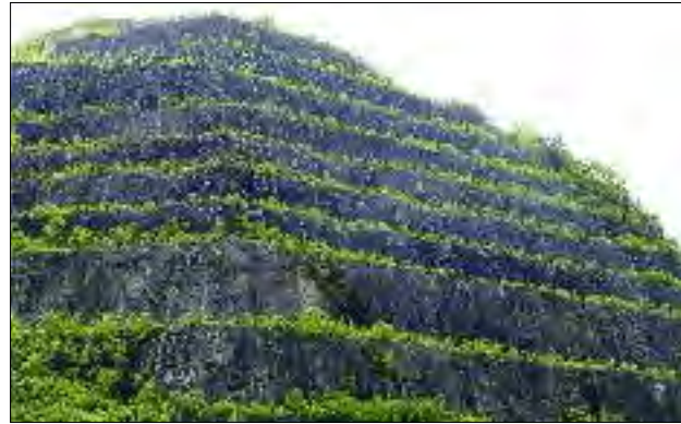
Varovalne terase ob Panamskem prekopu. FLICKR
