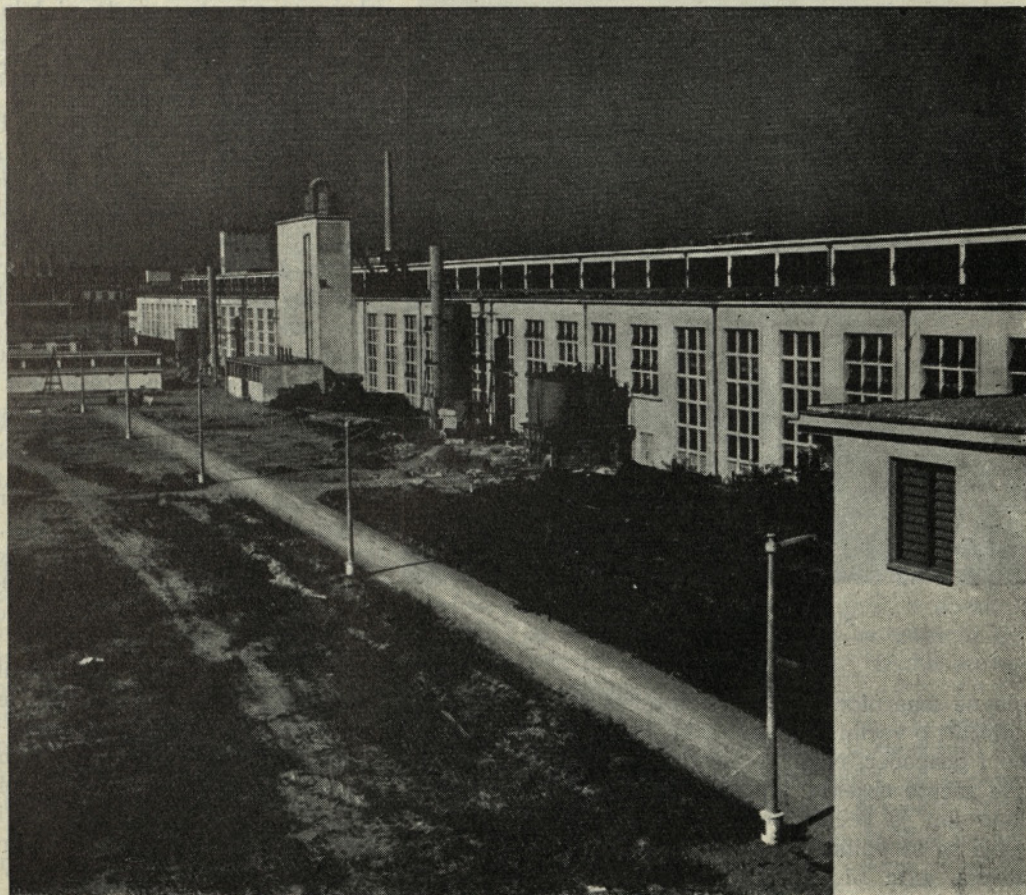
Pogled na obratno halo elektrolize
