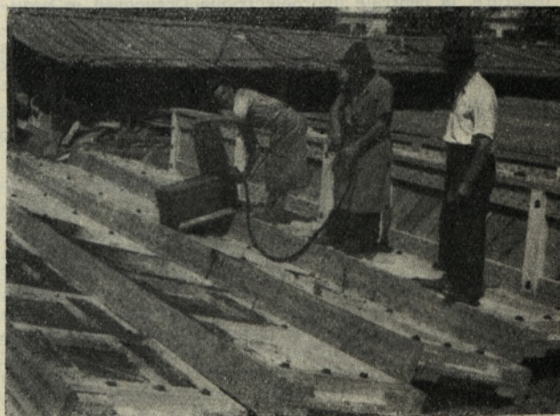
Sl. 3 Skropljenje nosilcev s karbolinejem v Mariboru
