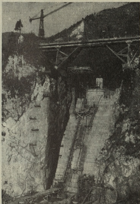
Sl. 32 Hidrocentrala v Mostah
