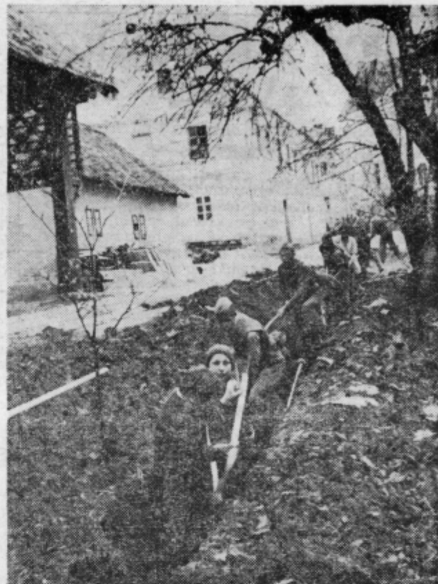
Vojaki in vaščani ob delovni akciji pri gradnji vodovoda na Dobjem letos aprila. (Foto: J. Sever)
