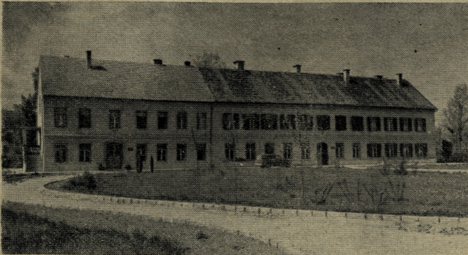
Upravno poslopje — v novem prizidku (levo) je hmeljarska šola.
