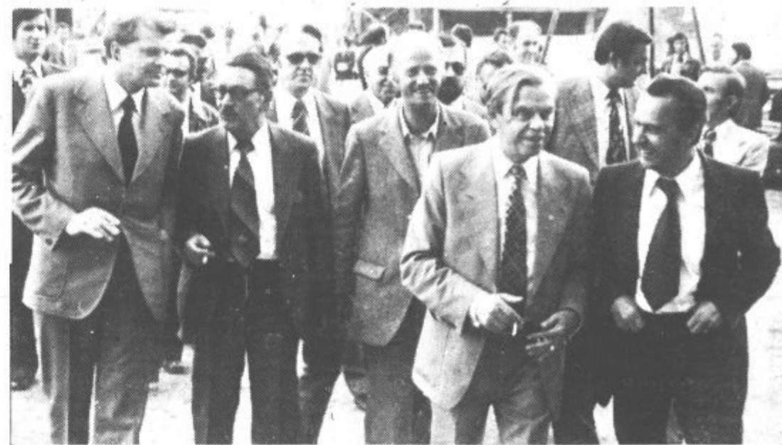
Gostje na gradbišču nove termoelektrarne Šoštanj IV.
