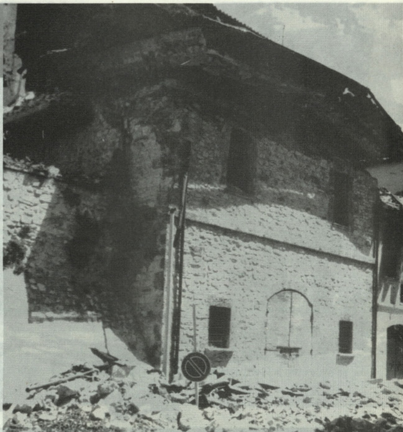
Slika 15: Sellano, Umbrija: masivne plošče niso preprečile porušitve neutrjenega kamnitega zidovja
