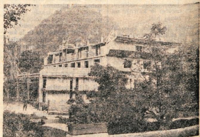
Zgradba v Kidričevi ulici v Kamniku bo v spodnjih prostorih namenjena trgovskim lokalom, v zgornjih prostorih pa bodo stanovanja. — Foto: T. Smolnikar
