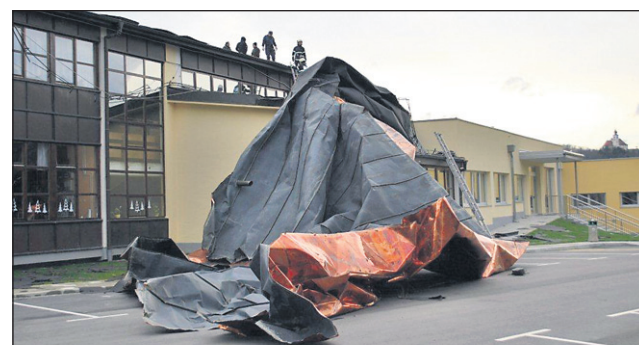
Na podlehniški osnovni šoli je božični močan veter uničil celotno bakreno kritino.
