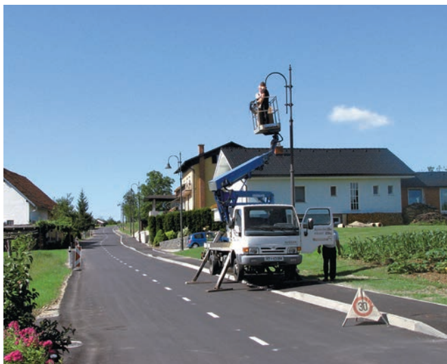
Izgradnja pločnika z razsvetljavo je pripomogla k varnosti in urejenosti kraja.
