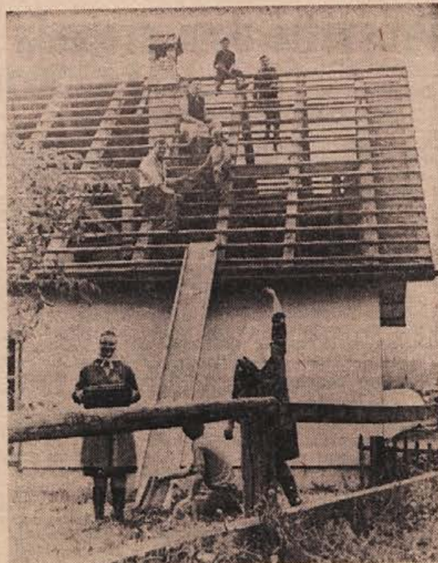
Prejšnji teden so Pionirjevi delavci razkrili in porušili hišo poleg sejmišča ob Cesti herojev v Novem mestu, ker bo ta prostor zavzela bencinska črpalka, za katero tudi že opravljajo zemeljska dela. Sejmišče bo podjetje DOMINVEST v kratkem prestavilo na Cikavo na desni breg Krke (Foto: Ivan Zoran)
