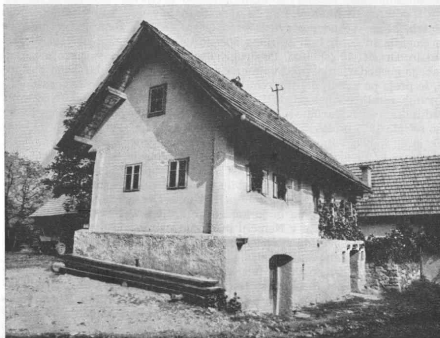
Sl. 8a (zgoraj). Mohorčičeva hiša pred predelavo; lastnik danes Miha Zabčič, št. 25 b (spodaj). Ista hiša, na zunaj prenovljena leta 1954
