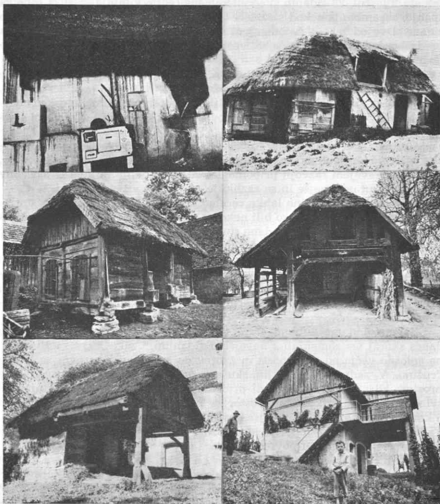
Sl. 9 (zgoraj levo): Kraševčeva veža z ognjiščem in emajliranim štedilnikom, sl. 11 (zgoraj desno): Jančin hlev s svinjakom, sl. 12 (v sredini levo): Nemanjškov svinjak, sl. 13 (v sredini desno): Jurčin skedenj z dero in kozolcem, sl. 14 (spodaj levo): Nemanjškov hiš z dero, sl. 15 (spodaj desno): Plutova obnovljena zidanica
