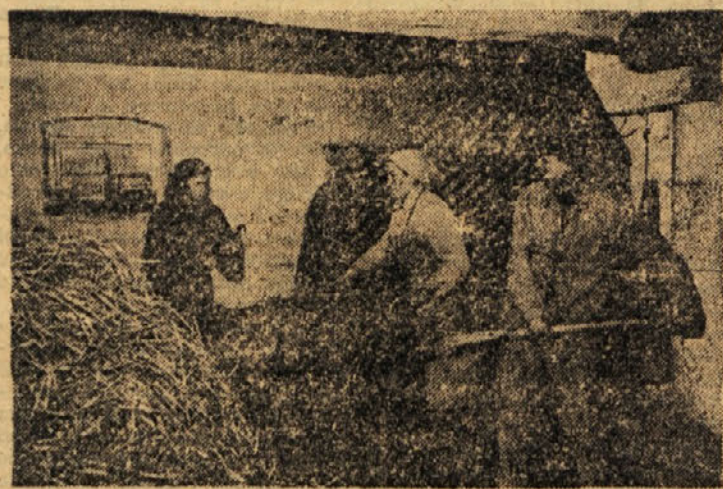
Prpriprava materiala za izolitne plošče
